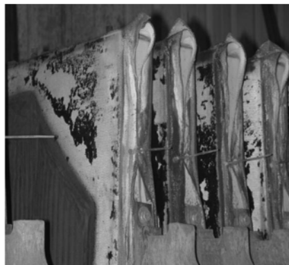
圖 7.3.2-3 脫水機老舊
