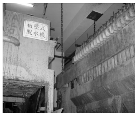
圖 7.3.1-5 脫水機老舊
