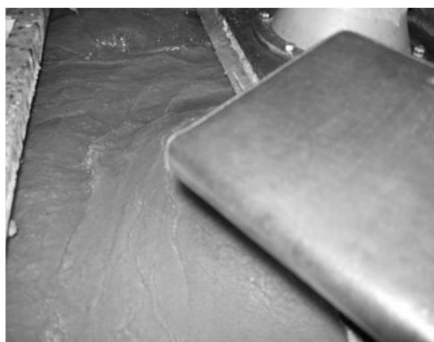
圖 7.3.1-2 慢混槽攪拌情形
