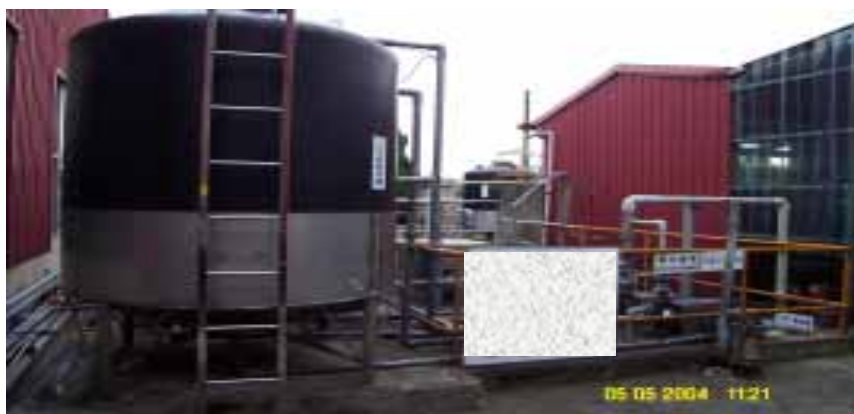
圖 3 污泥貯存及濃縮槽停留過久
