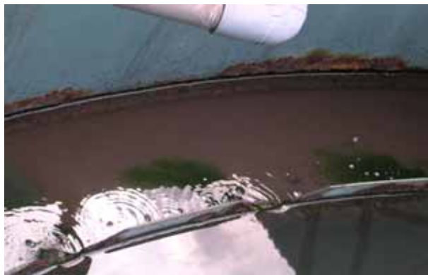
圖 4 案例工廠沉澱槽出流渠滋生藻類
