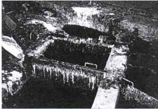
圖 3 改善前之籠式攔污柵（被碎皮屑堵塞嚴重）
