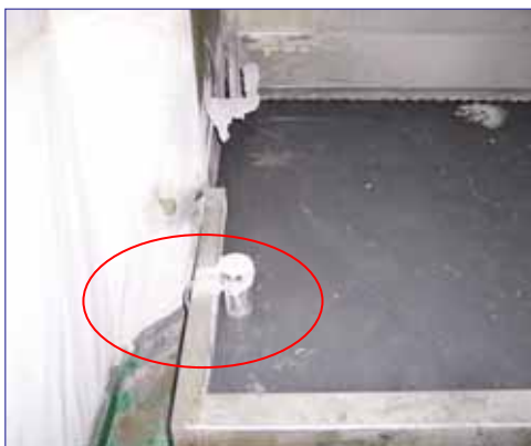
圖 7 案例工廠加裝水位控制器改善狹縫氣罩效率
