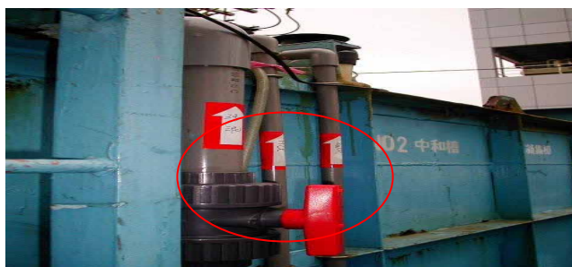
圖 5 案例工廠污泥迴流改善方式
