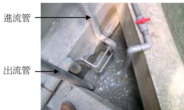
圖 5 案例工廠污泥濃縮槽短流狀況
