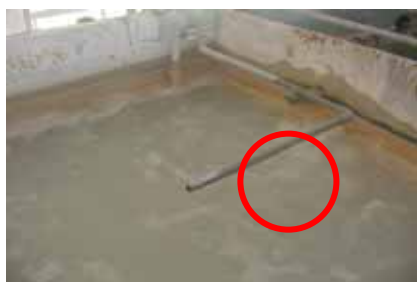
圖 3 pH 調整池曝氣攪拌不均
