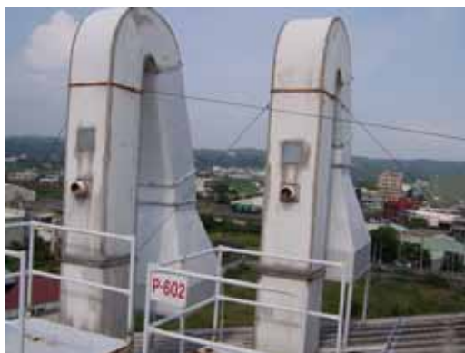
圖 8 案例工廠煙道出口加長並加裝過濾棉
