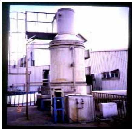
圖 6 案例工廠廢氣洗滌塔設置 pH、壓力錶及廢水導流管以提升效率
