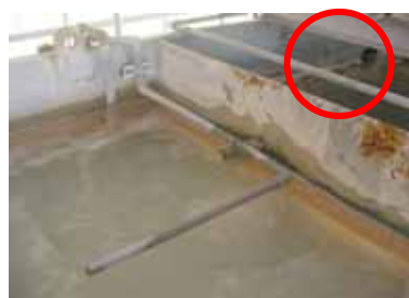
圖 4 慢混池液面溢流距離過短
