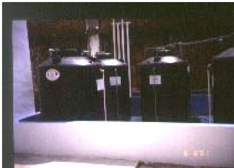
圖 4.6-2 化學藥液槽設置防溢堤
