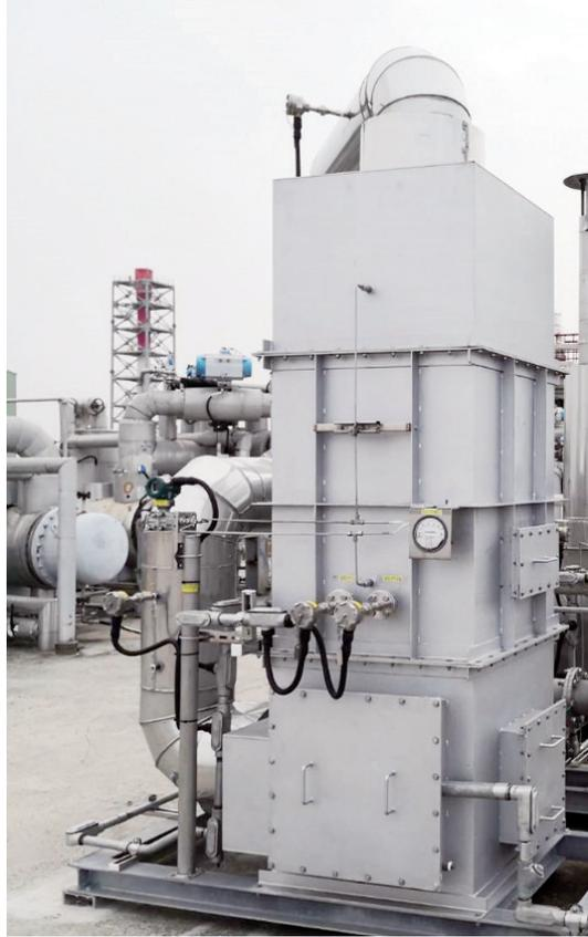
圖 6 觸媒熱氧化系統外觀圖
