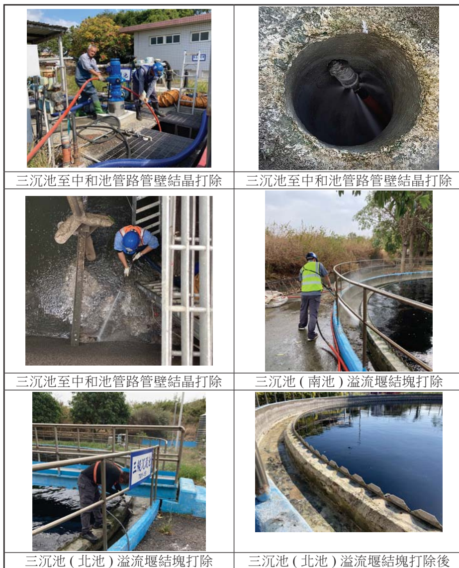
圖 12 大甲幼獅污水處理廠化學處理單元池體積垢(結晶物)清除
