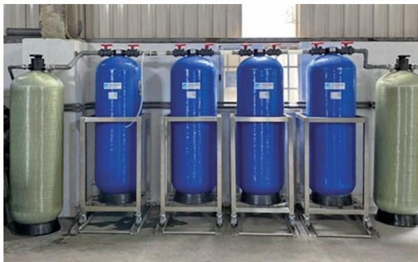
圖 6 LCD 玻璃奈米孔洞材料吸附處理系統
