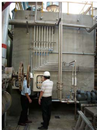
圖 6 排氣生物濾床處理流程及設施側面
