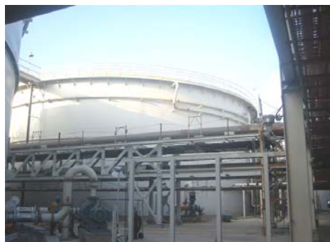
圖 9 台灣最大煉油及化工業廢水 MBR 處理廠(22,500 m 3 /day)
