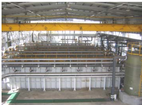
圖 9 台灣最大煉油及化工業廢水 MBR 處理廠(22,500 m 3 /day)
