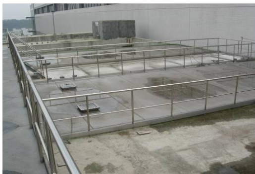
圖 7 台灣第一套 UASB/MBR(1,500 m 3 /day)高濃度有機廢水處理廠
