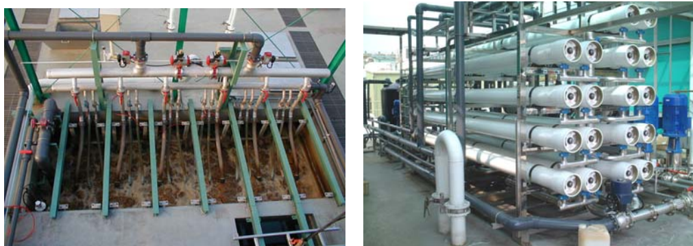
圖 2 台灣第一套 MBR/RO (1,270 CMD)實廠(水回收率達 75%)
