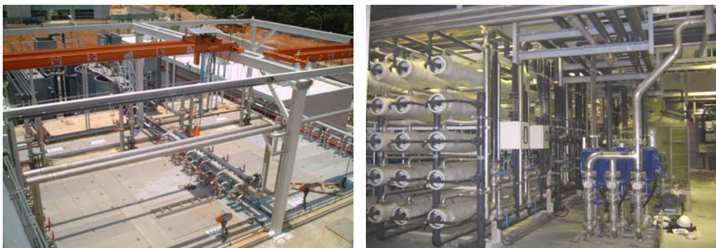
圖 3 MBR/RO 處理廠( 5,000\text{ m}^3/\text{day} , 水回收率 80%)
