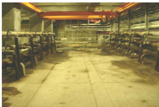
圖 6 台灣最大規模 MBR/RO/AOP 處理廠(22,500 m 3 /day, 水回收率 88%以上)
