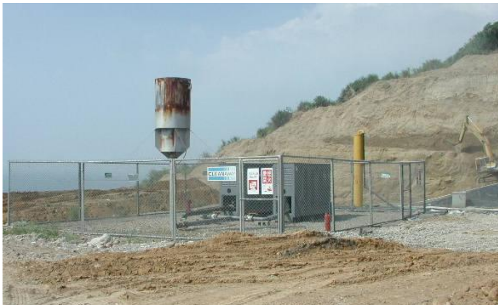
圖 3 第 1,2 期已完成安裝之沼氣收集點火系統
