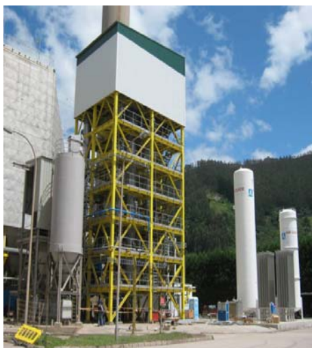
圖 3 西班牙 La Pereda CaO Looping 示範廠相片 (1.7MWth)
