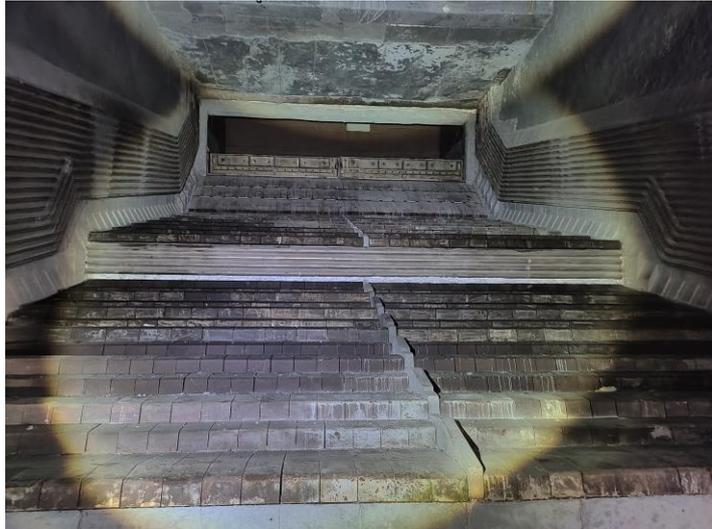
圖 2 水冷式爐床及水冷壁
