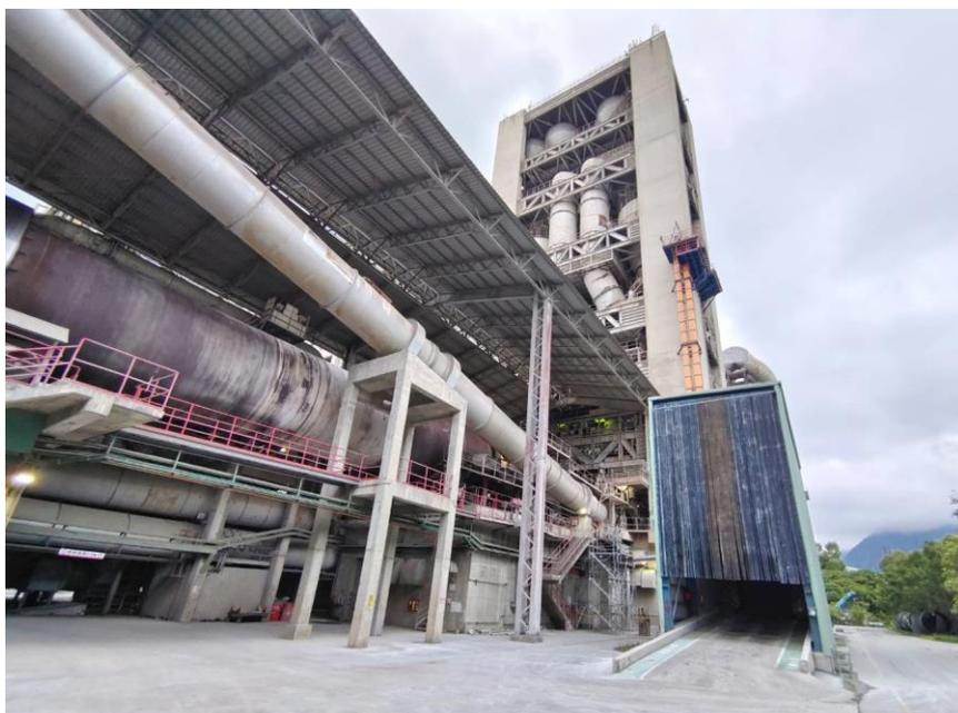
圖 7 水泥窯之預熱機、旋窯及替代燃料投料口外觀
