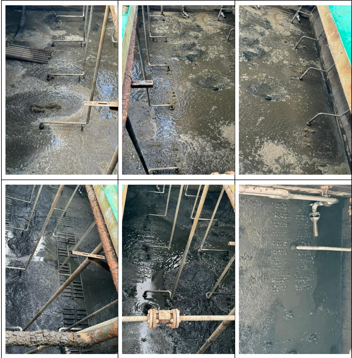
圖 1 原系統更新曝氣設備前的樣式，污泥覆蓋著膜片式散氣管
