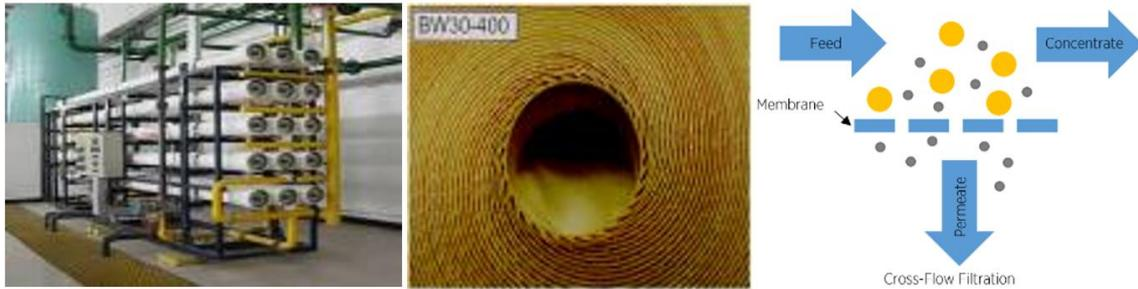
圖 8 中水廠使用之 RO 型式圖(螺旋纏繞式)
