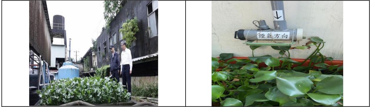
圖 3 鍋爐含 CO<sub>2</sub> 排氣導入 2 池水生植物養殖池
