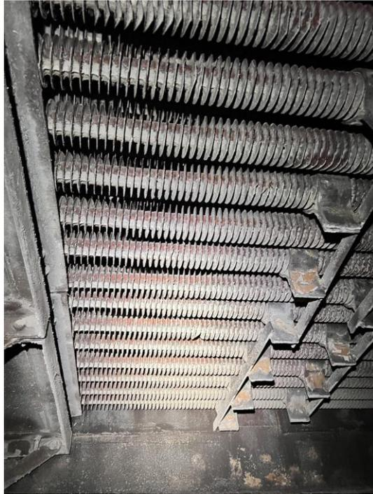
圖 3 煙道後段外部節熱器
