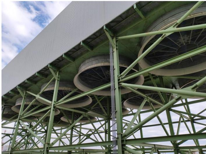
圖 4 高效率氣冷式冷凝器
