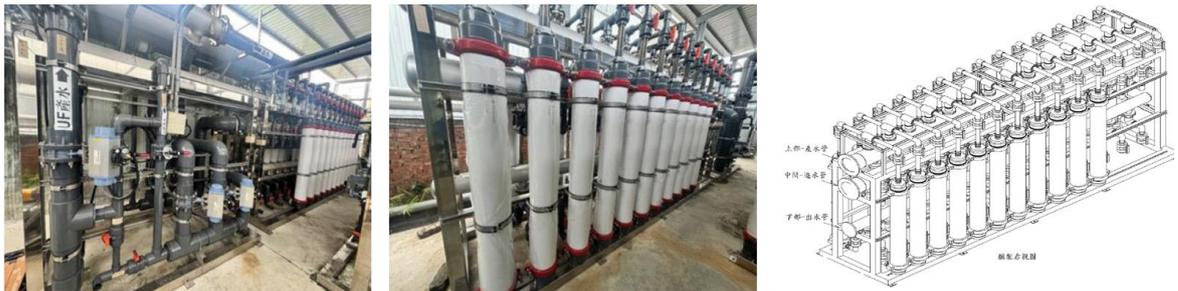
圖 11 UF 系統構造
