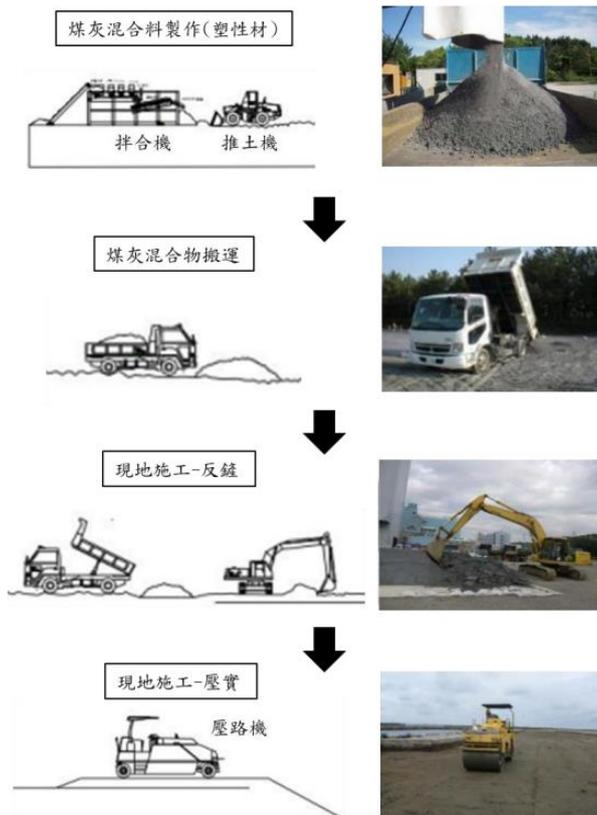
圖 6 灰渣混合料-塑性材現地製造及施工方式
