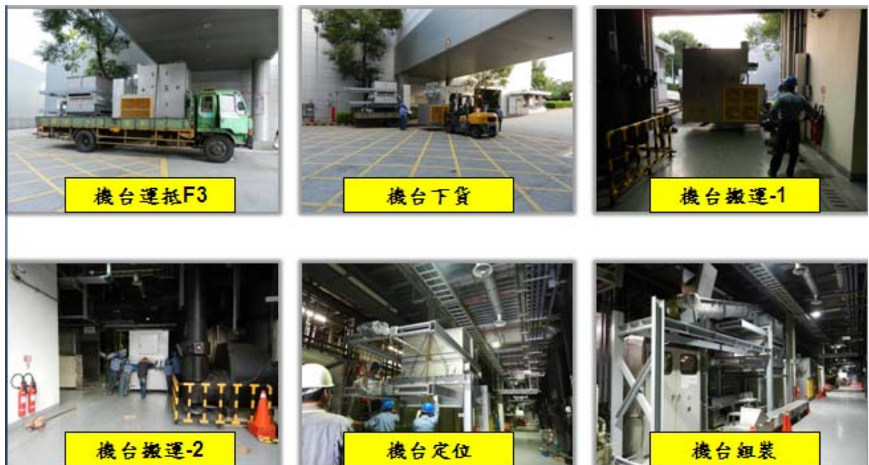
圖 7 冷凝式乾燥機運送及組裝
