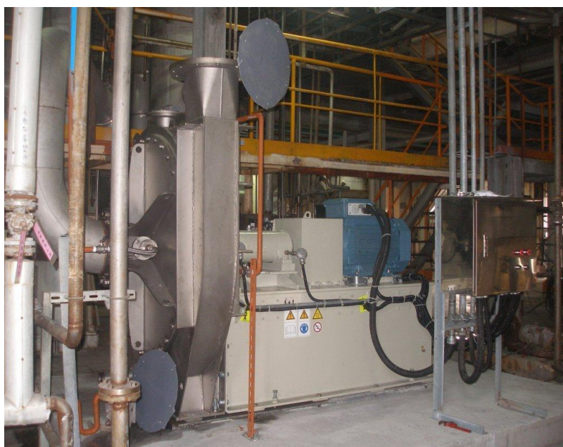
圖 7 改善後之 MVR 系統
