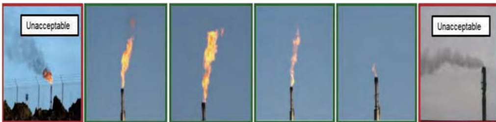
圖 4 不同 S/VG 之燃燒塔運行樣態 (Flare Steam-Assist Optimization, 2012)
