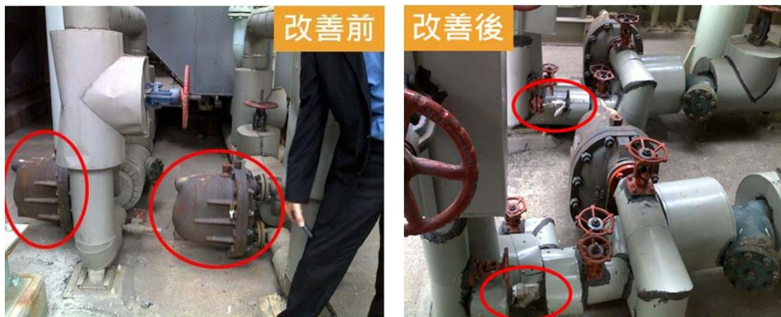
圖 3 1 吋節汽系統取代 4 吋傳統祛水器
