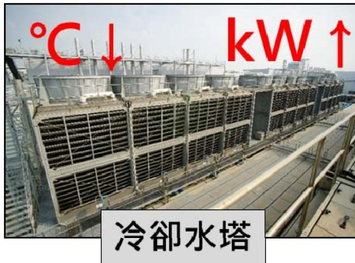
圖 8、冷卻水溫越低則耗能越高
