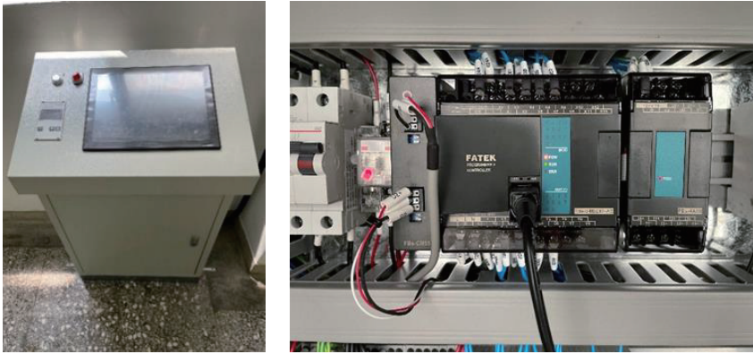
圖 12 人機介面可程式邏輯控制電控箱(左)和可程式邏輯控制器(右)
